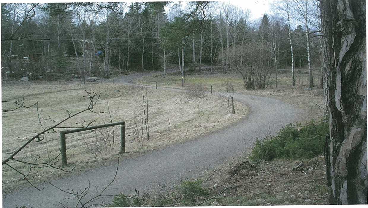
Rudsjöns nedre begränsningsvall. Då med dammlucka och som idag med väg.
